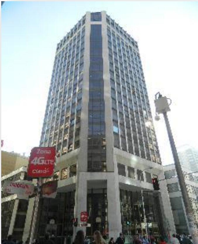
Transporte vertical / ascensores regenerativos
